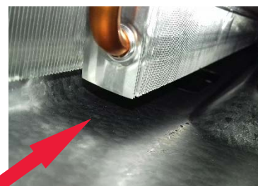
A KONDENZÁTOR MINDÖSSZE 10 MM-RE TALÁLHATÓ A CSEPPTÁLCA-CSATORNA FELETT ÉS AZT TELJES HOSSZÁBAN FŰTI
