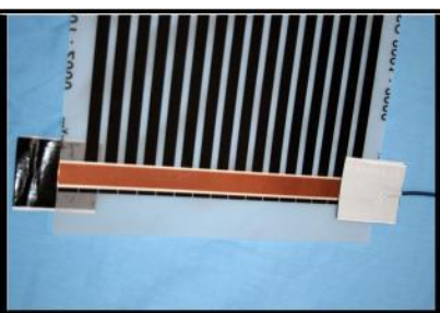
04. 7 Vízhatlan szigetelő tapasz rögzítése a fűtőfilm végek lezárása
