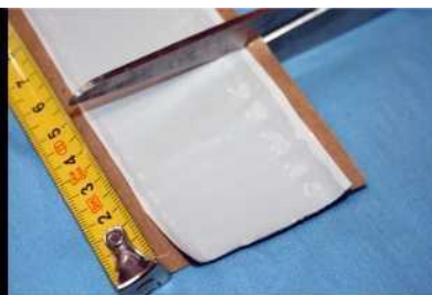
04. 1 Vízhatlan szigetelő tapasz méretre vágása
