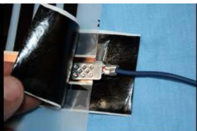
04. 4 Vízhatlan szigetelő tapasz rögzítése felülről
