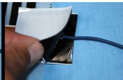
04. 5 Vízhatlan szigetelő tapasz rétegek összeillesztése
