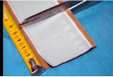
4. 2 Vízhatlan szigetelő tapasz méterre vágása
