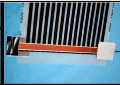
4. 8 Vízhatlan szigetelő tapasz rögzítése a fűtőfilm végek lezárása
